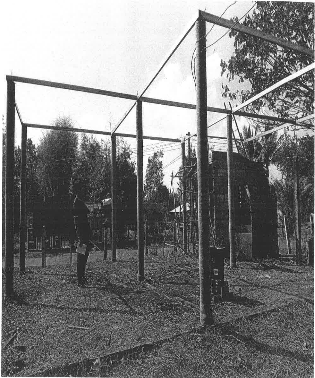
ภาพโครงสร้างบ้าน นายถนอม อุ๋นใจ ม.๖ ต.เชิงชุม อ.พรรณานิคม จ. สกลนคร
